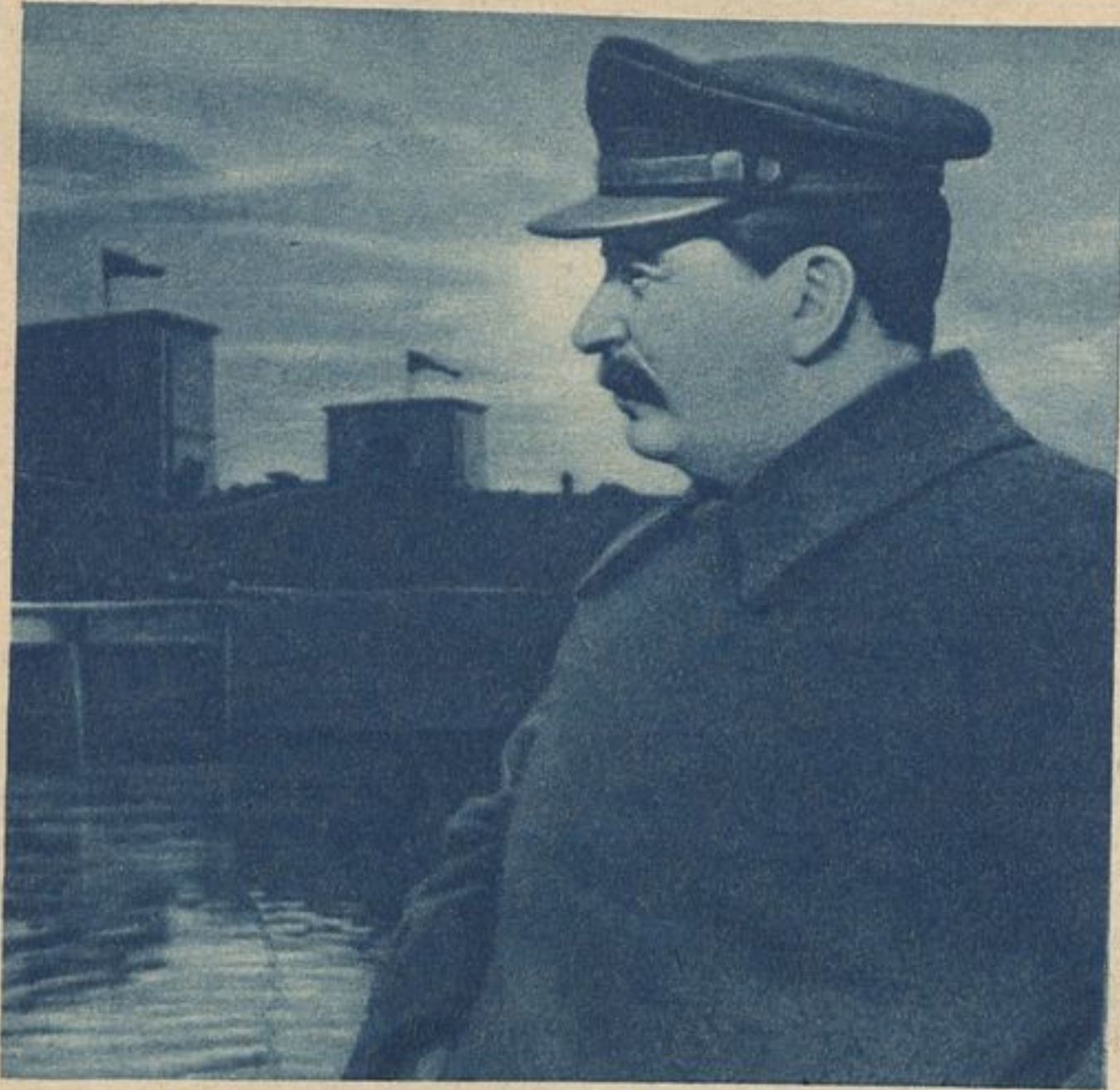
Товарищ Сталин осматривает строительство канала.
